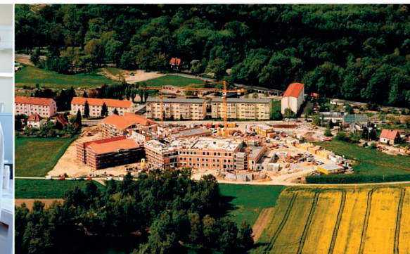
Bau des St. Johannes im Jahr 2000
