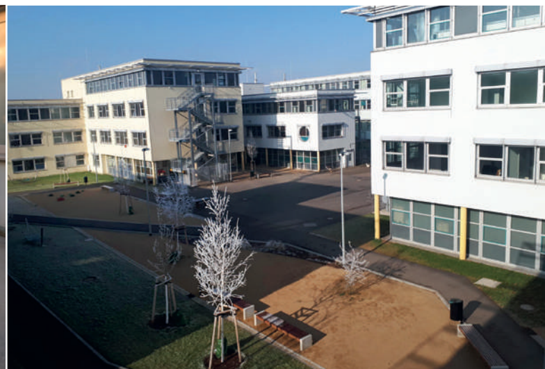
Neue Sanitätsstation in der EA Dölzig/Schkeuditz
